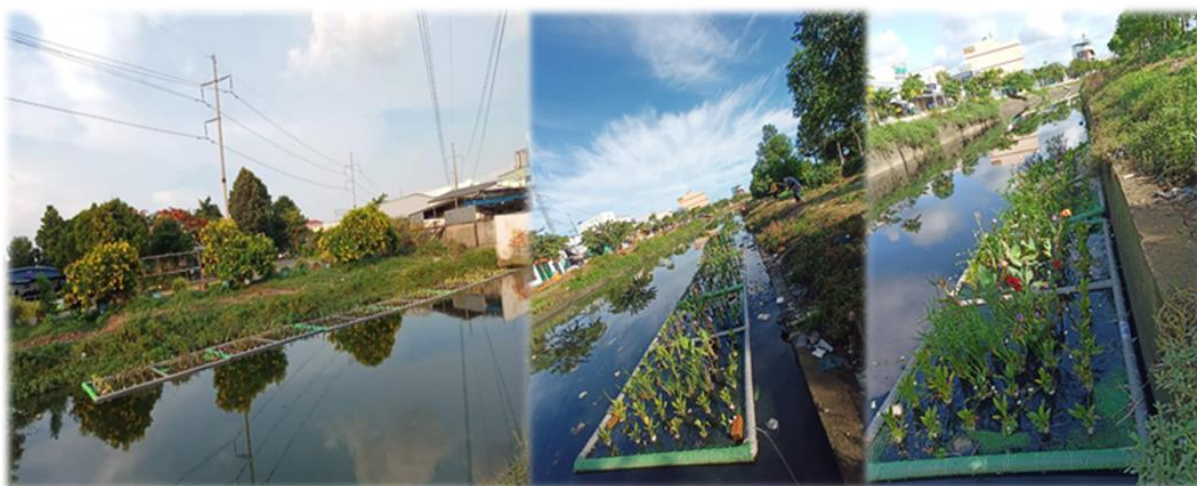
Hình 2: Mô hình ứng dụng CFWs tại kênh Búng Xáng, thành phố Cần Thơ, Việt Nam
