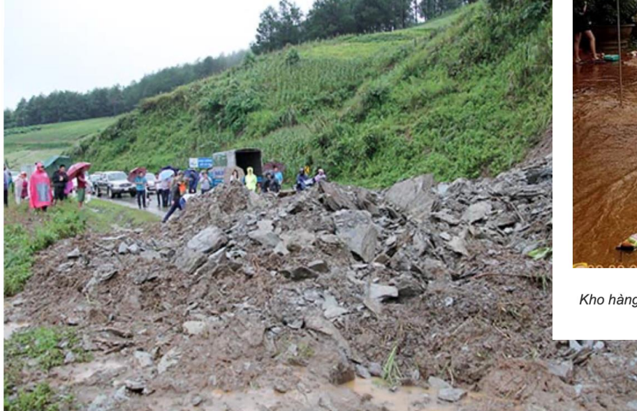
Khối lượng lớn đất đá bị sạt xuống đường Quốc lộ 6, đoạn qua địa phận bản Bó Nhàng 1, xã Vân Hồ, huyện Vân Hồ. Ảnh: Báo Sơn La
