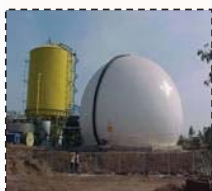
ก๊าซชีวภาพที่ เทศบาลนครระยอง (625 kW)
