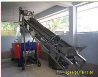
เครื่องลดขนาดขยะรวม แบบ Shear Shredder
