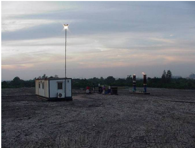
ຮູບ. 2.32 ສະໜາມຂີ້ເຫຍື້ອອານາໄມປະກອບດ້ວຍລະບົບເອົາແກສຄືນມາໃຊ້ຢູ່ປະເທດໄທ (ຖ່າຍຮູບໂດຍ ດຣ ຄົມສິບ ວັງຍາວ Komsilp Wangyao).
