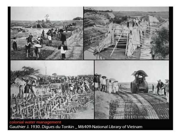
Digues de l'é catégorie le Digue prenant appui sur bon terrain 7.00 Côté Fleuv 2º Digue avec mares latérales 7.00 Digues de 2° catégorie Légende de cote(12,00) à Masques correpés . Rembleis corrorés non ébauché Remblais ordinaires à prévoir for for sysem of rivers in the delta Gauthier J. 1930. Digues du Tonkin, M6409-National Library of Vietnam
